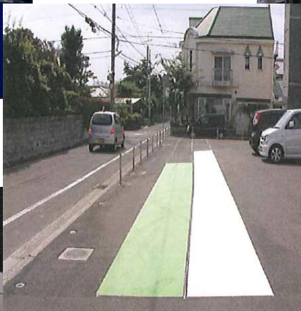
アスファルト路面
