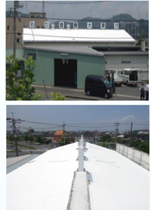
チルコートHSP 施工後
